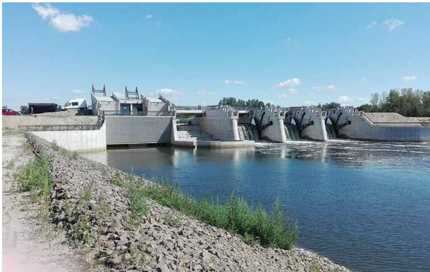
Segmentové uzávěry s jezovou klapkou+čističí stroje, projekt: VD ŽELIEZOVCE, SK, rok realizace: 2016
