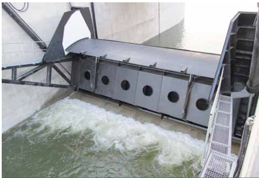
Segmentový uzávěr s jezovou klapkou, projekt: VD ŽELIEZOVCE, SK, rok realizace: 2016
